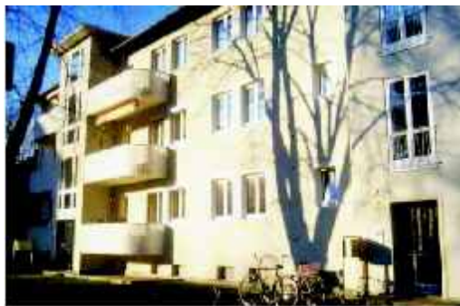
Saniertes GEWOBAU-Gebäude in Erlangen-Süd
