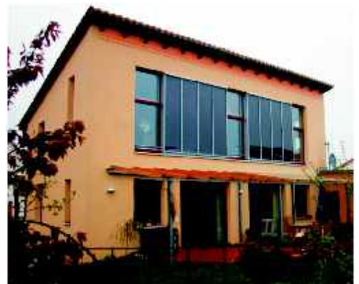
Bauherr: Fam. Heinzelmann; Architekt: Dr. Schulze Darup; Zambellstraße 22
