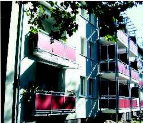
Saniertes Wohngebäude Hartmann-Straße
