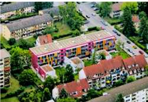
Dach mit Photovoltaik
