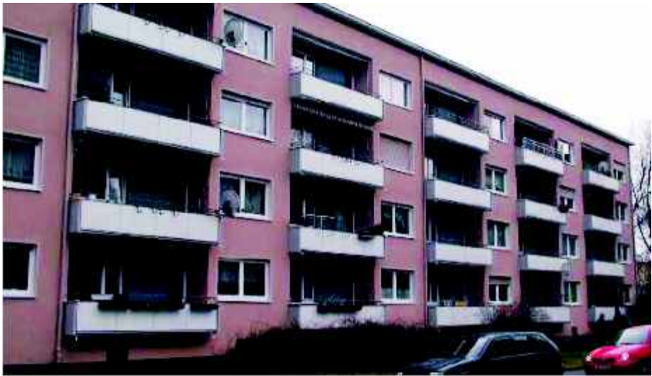
Saniertes GEWOBAU- Gebäude in der Hedenusstraße
