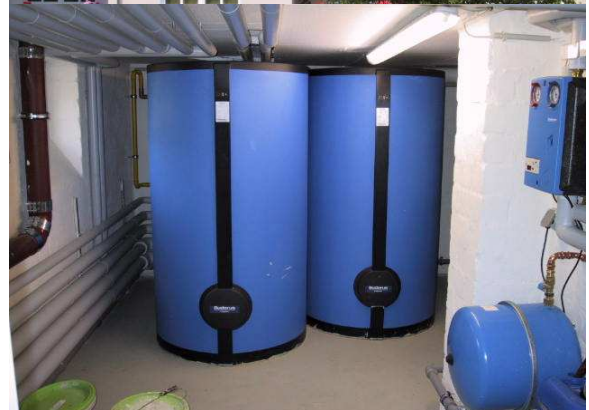
Abb. 2: Die zwei 750 l Trinkwasserspeicher mit der Pumpenanlage zur Zirkulation der Solarflüssigkeit (rechts an der Wand)
