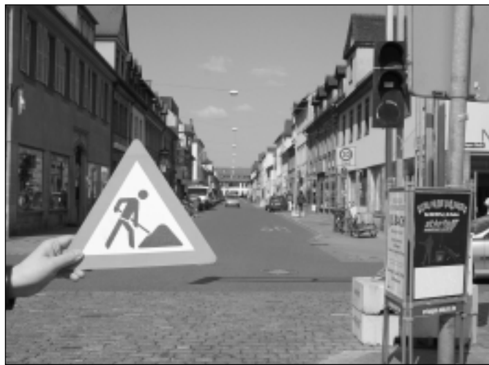
Hier verlegen in Kürze die ESTW Gasleitungsrohre.
