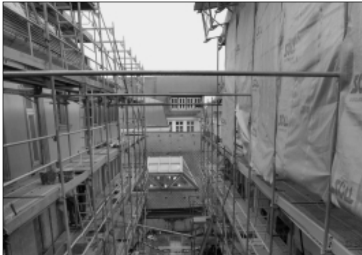
Derzeit noch eine Baustelle: Der Innenhof des Palais.
