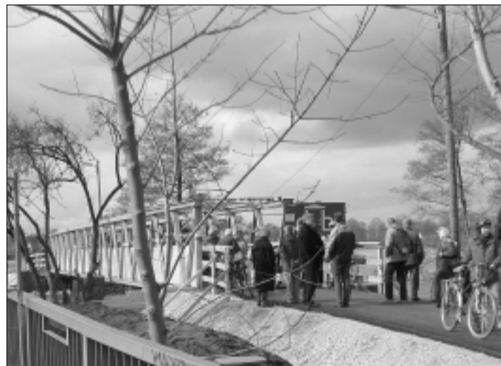
Eine Stahlfachwerkkonstruktion wird voraussichtlich bis Jahresende die wichtige Radverbindung vom Stadtzentrum in den Erlanger Westen ermöglichen. Foto: Stadt Erlangen
