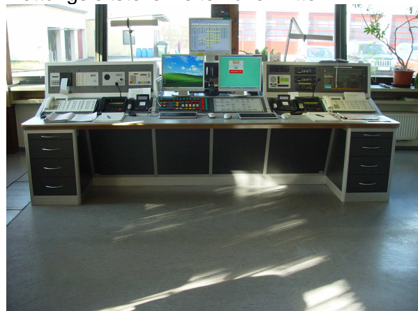
Der neue Tisch in der Einsatzzentrale
