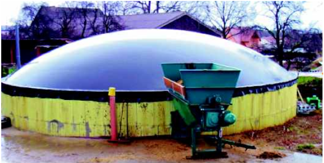
Fermenter + Feststoffzuführung und Mixer. Gaserzeugung
