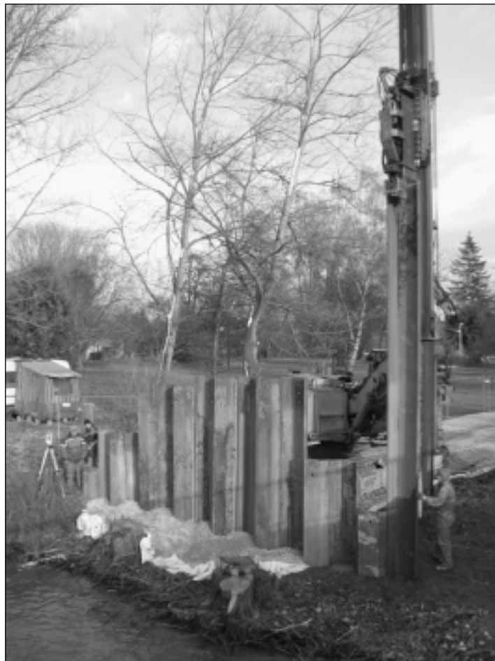
Sie soll schon bald nutzbar sein: die Behelfsbrücke am Wöhrmühlsteg. Foto: Stadt Erlangen
