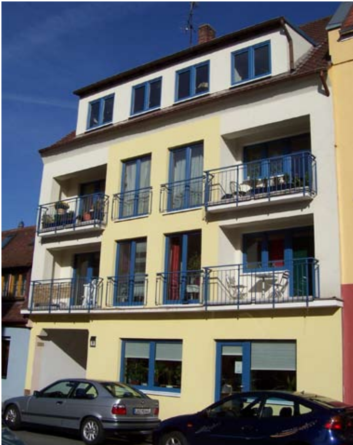
Mehrfamilienhaus in der Feldstraße mit neuen Fenstern und Vollwärmeschutz sowie einer Heizenergiezufuhrversorgung mit Blockheizkraftwerk
