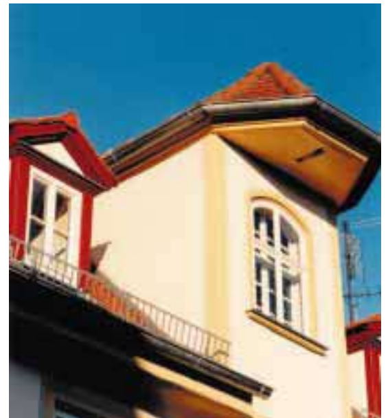
Aufzugsanker aus dem frühen 18. Jahrhundert. Ein charakteristisches Detail in der Erlanger Innenstadt, das es zu erhalten gilt
