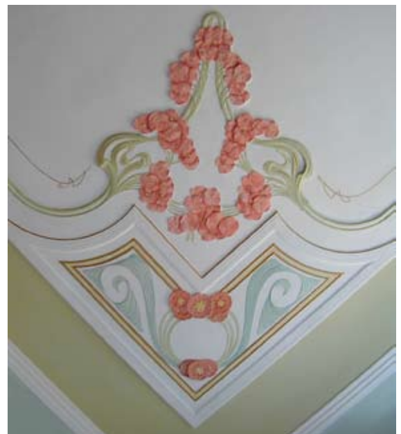
Wer hätte gedacht, dass sich solche Schätze in der ehemaligen „HEKA“ verbergen – Stuckdecke nach der Sanierung
