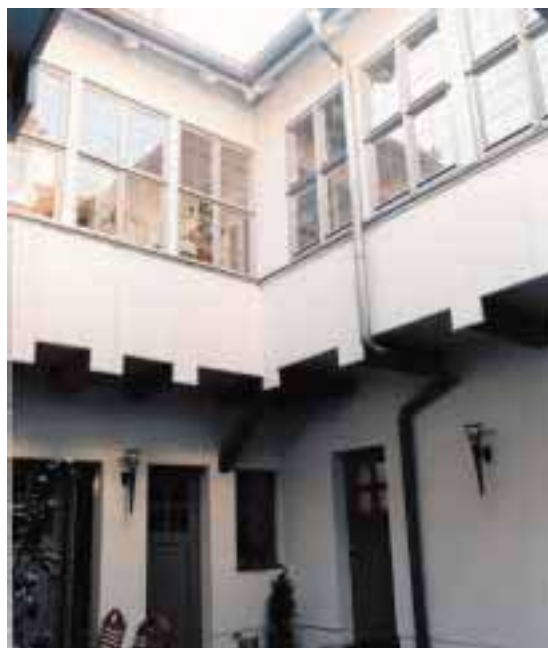
Die Einmaligkeit wird danach deutlich. Die denkmalgerechte Sanierung führte zu einer enormen Steigerung der Wohnqualität und des Gebäudewertes
