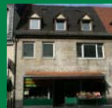
Vor der Sanierung –gestalterische Mängel an Fassade (Markise), Fenster und Ladeneinbauten
