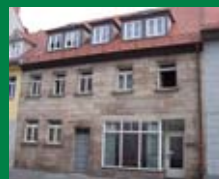
Beseitigung der Missstände und Verbesserung der Wohnverhältnisse- Modernisierungsmaßnahme in der Neuen Straße
