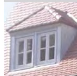
Neue Straße 23 – Detail
