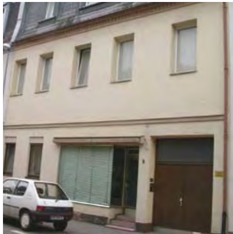
Stubenlohstraße 8 Zustand vor der Sanierung
