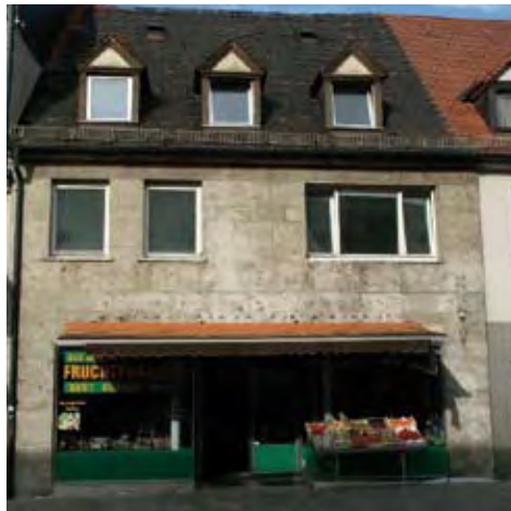
Hauptstraße 77 Zustand vor der Sanierung
