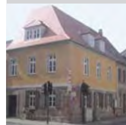
Neue Straße 23 – saniertes Gebäude
