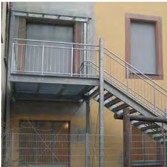
Markgrafentheater / Redoutensaal, von der Wasserturmstraße, Anbau einer Fluchttreppe zum Saal Foto: Stadt Erlangen
