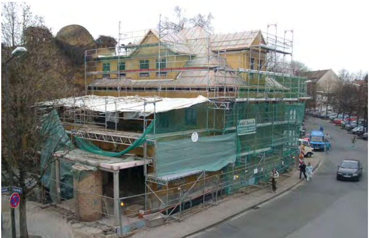
Kulturzentrum E-Werk – Sanierung des ehemaligen Wohnhauses, im Vordergrund der künftige Anbau für den Kartenvorverkauf
