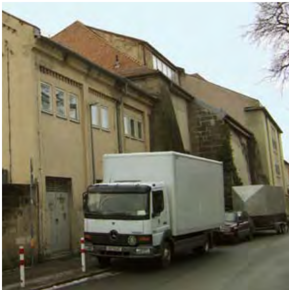
Markgrafentheater – Rückfassade mit Bühnenhaus und Nebenräumen Foto: Stadt Erlangen
