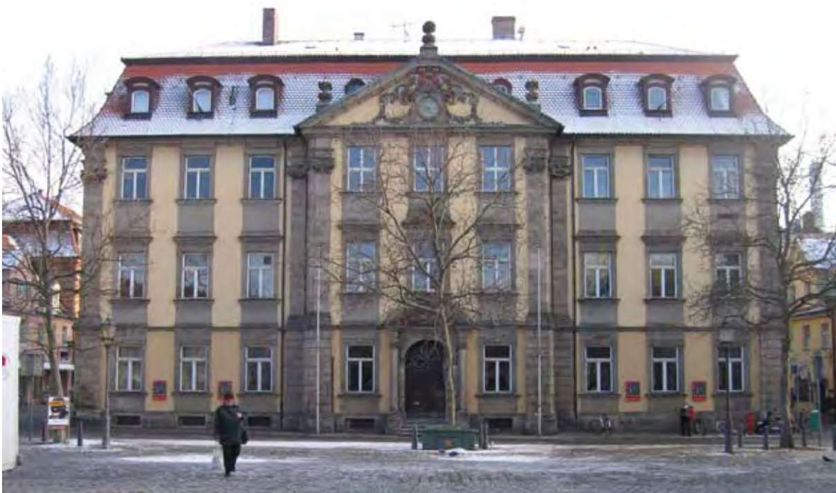
Palais Stutterheim, vom Marktplatz aus gesehen – Zustand vor der Sanierung
