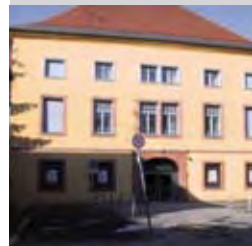
Eingangsbereich Markgrafentheater / Redoutensaal, Ansicht Wasserturmstraße
