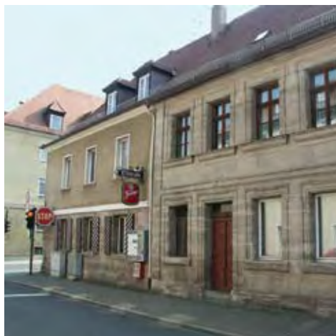
Neue Straße 23 Zustand vor der Sanierung
