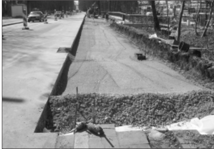
Keine Seltenheit in diesen Tagen: Straßenbaustellen im Stadtgebiet. Foto: Stadt Erlangen
