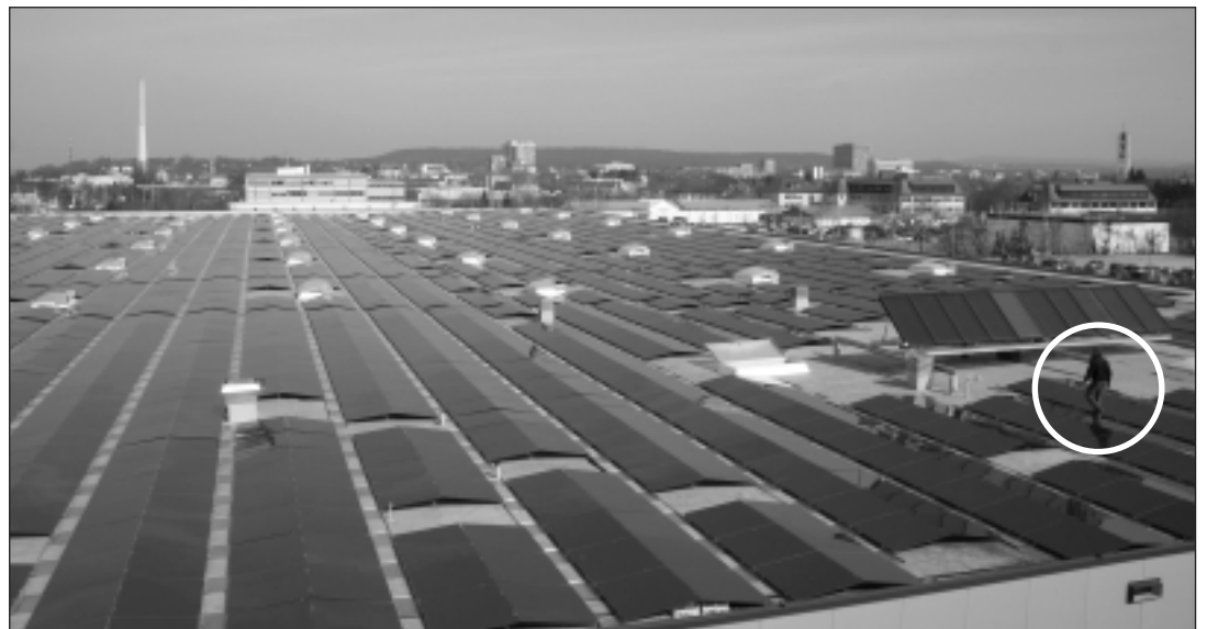
Der Blick auf die Fahrzeughalle des städtischen Bauhofs verdeutlicht eindrucksvoll die Ausmaße der PV-Anlage. Foto: Stadt Erlangen
