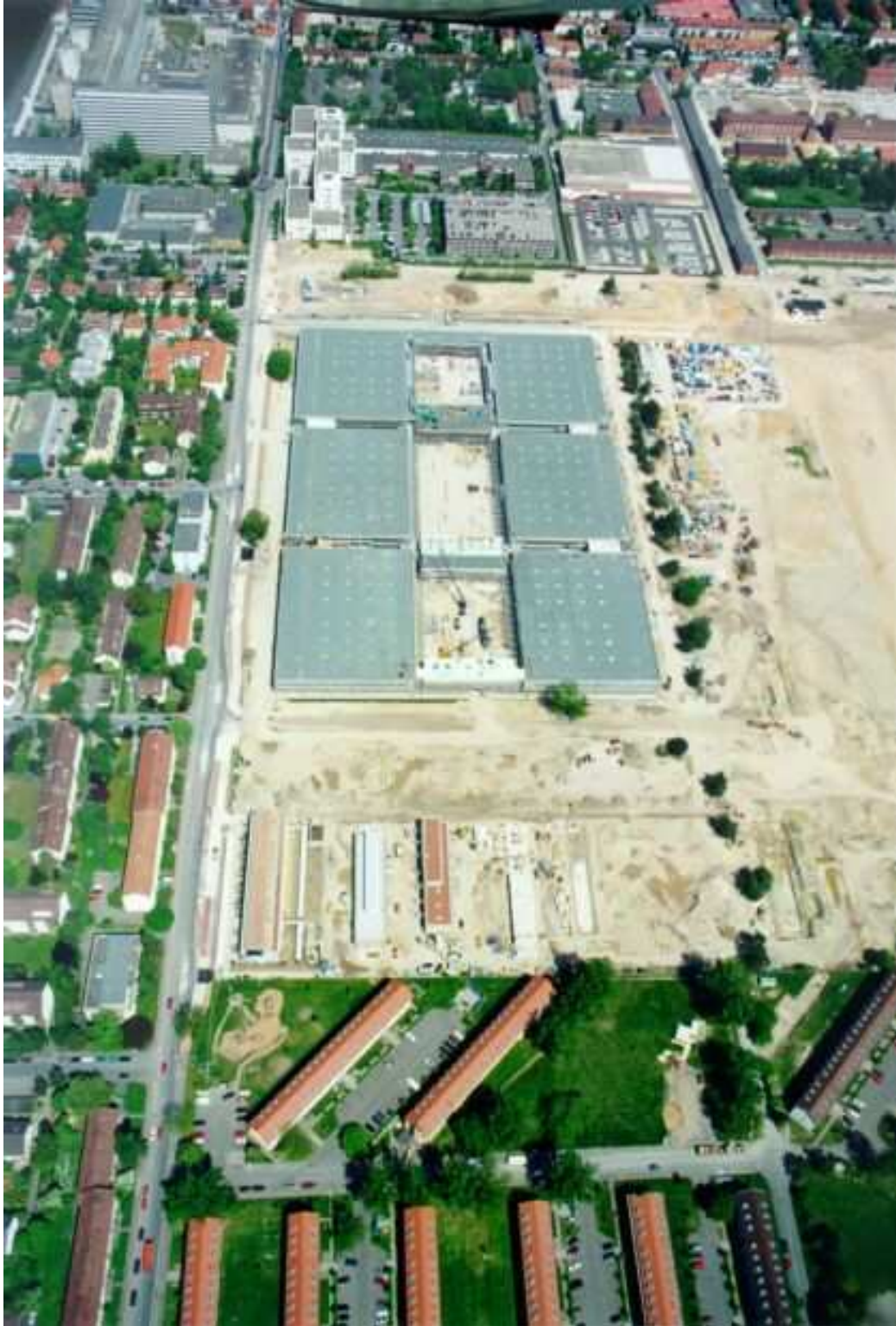
Neue Produktionsanlage für Medizintechnik auf dem ehemaligen Exerzierplatz
