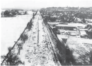
Bild: Aufgefülltes Kanalbett, um 1960 (Foto aus der Studie „Stadtentwicklung westlich des Bahnhofs“ von 1990 - Fotograf: unbekannt)
