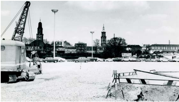
Bild: Der Großparkplatz als Baustelle (Fotograf: Gertold Glasow - Stadtarchiv VLA.b.1127)
