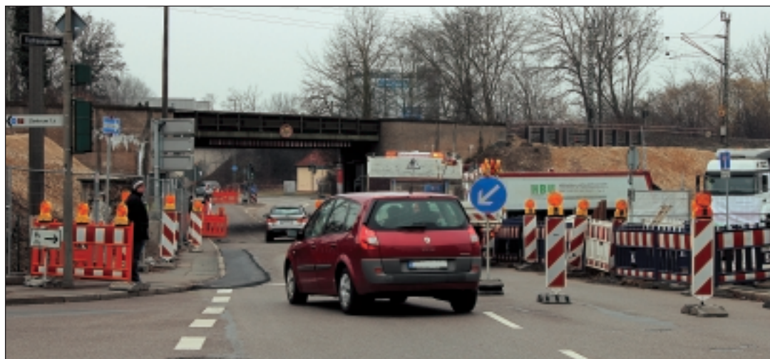
Vergangenen Montag haben die umfangreichen Arbeiten in der Martinsbühler Straße begonnen.
