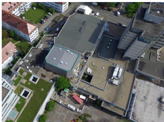
Luftbild mit neuer Dachlüftungszentrale
