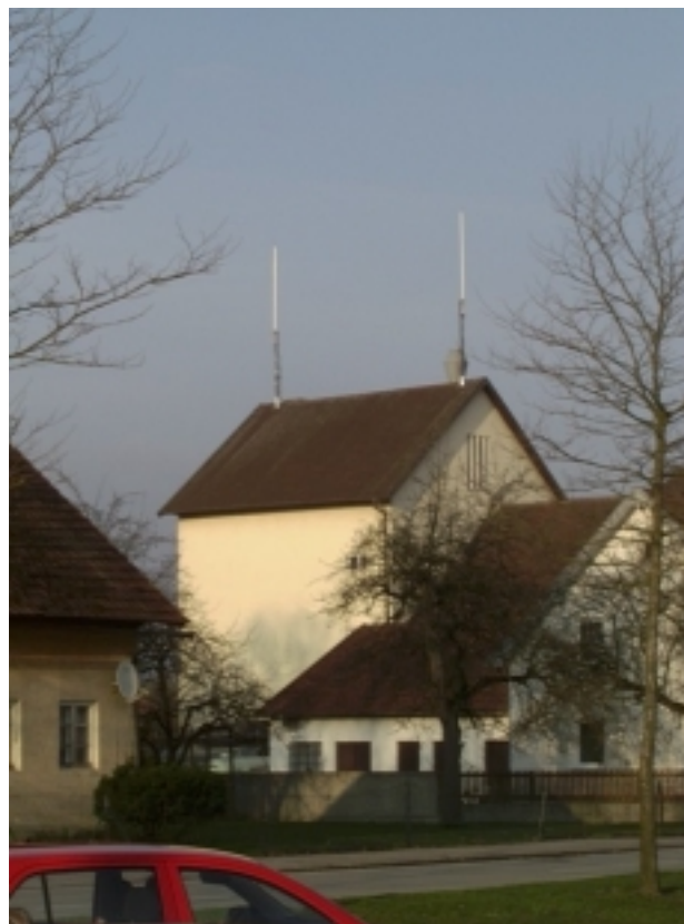
Abb. 1: Beispiel für eine Mobilfunksendeanlage mit omnidirektionalen Antennen
