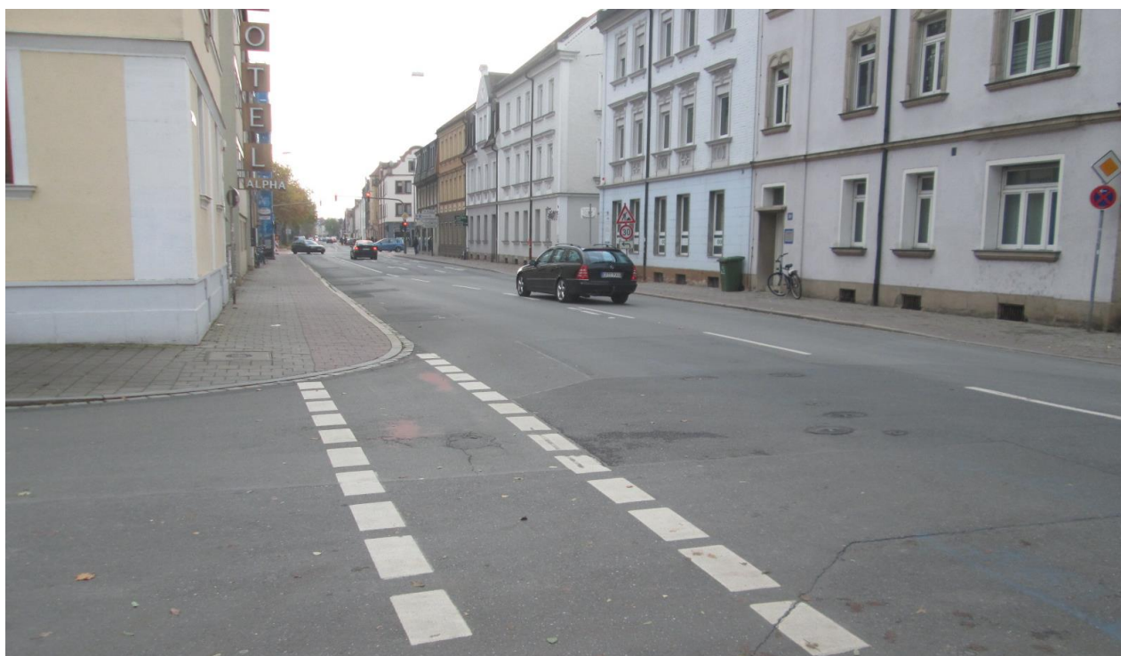
Zunächst wird die Loewenichstraße in der Zeit von Anfang März bis Mitte Juni fertiggestellt. Foto: Stadt
